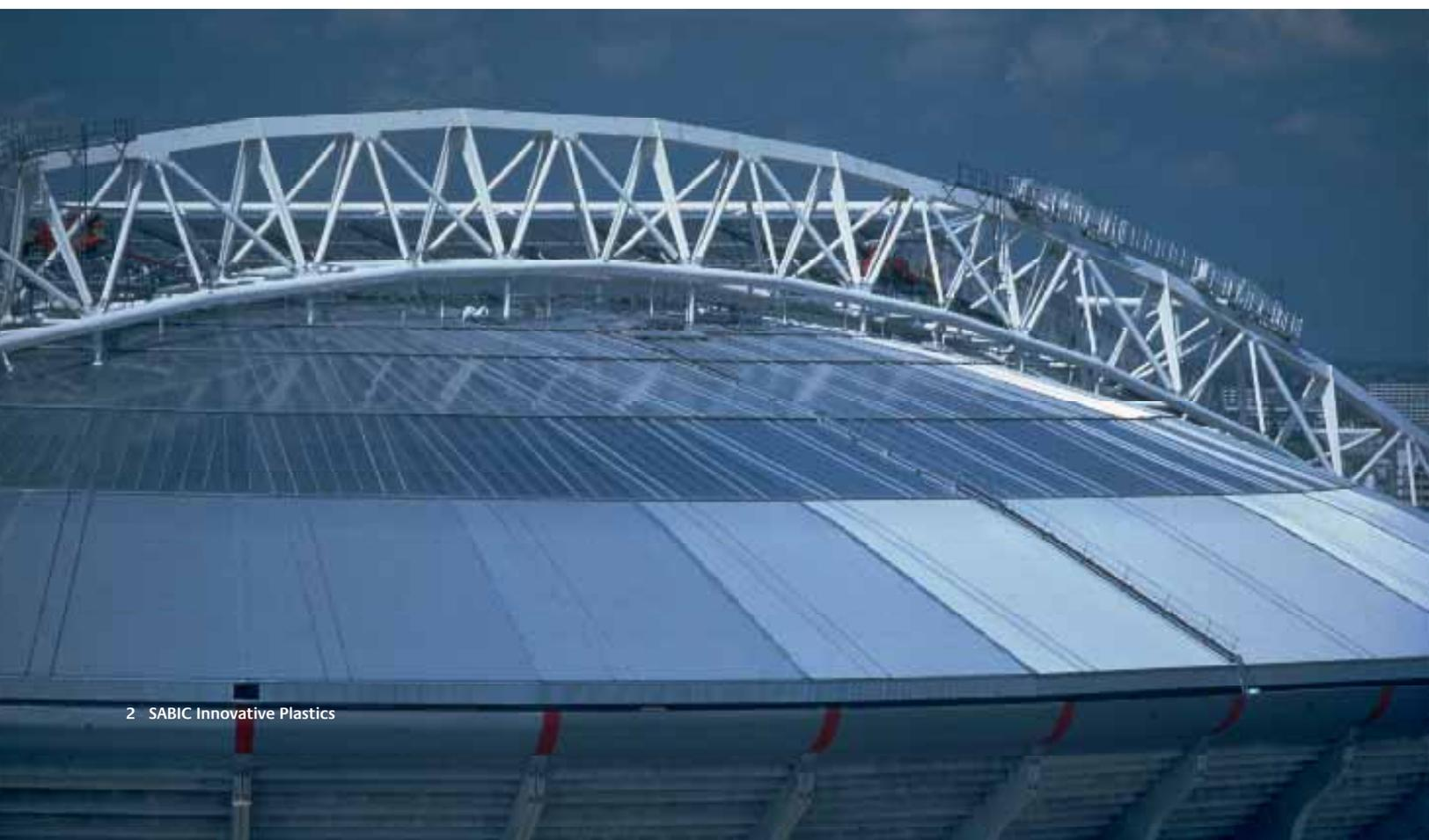
La placa Lexan\* Thermoclear Plus\* tiene por ambos lados una superficie protegida contra radiación UV patentada que le confiere una resistencia superior a la intemperie.
